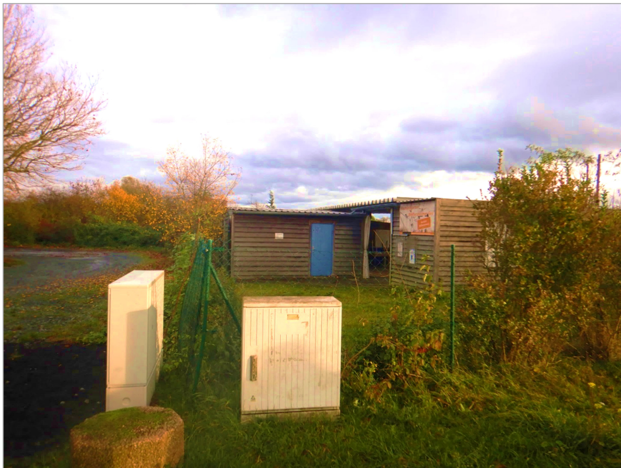
Abb. 8 Bestandsgebäude „Hochseilgarten Wölfersheimer See“ (Begehung 20.11.2023).
